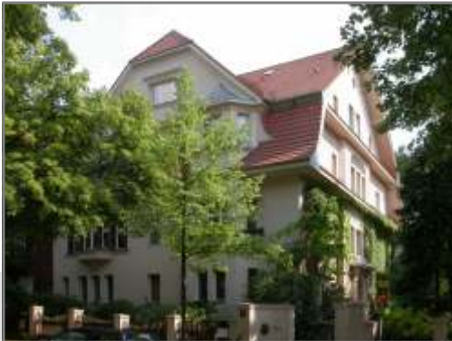
Lyckallee 16, in Berlin Westend Planung – Ausschreibung – Bauleitung Dach- u. Fassadeninstandsetzung, 2003
