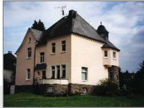
Wahlscheiderstr. 32, in Wahlscheidt Planung – Ausschreibung – Bauleitung Fassadeninstandsetzung, 1998
