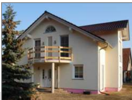
Zülichendorfer Weg 6, in Gottsdorf Planung - Bauleitung Neubau eines Einfamilienhauses, 2007/2009
