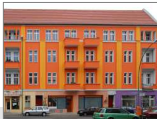
Gustav Adolf Str. 168, in Berlin Weißensee Planung – Ausschreibung Dachgeschoßausbau und Modernisierung eines MFH, 2007/2008
